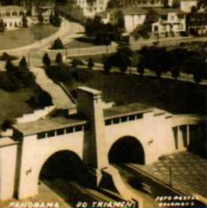
Vista do Túnel sob o Parque Trianon (face norte) após a construção do pórtico, rampas de acesso e ajardinamento. Postal, autor não identificado, s/d. Coleção Particular Benedito Lima de Toledo
